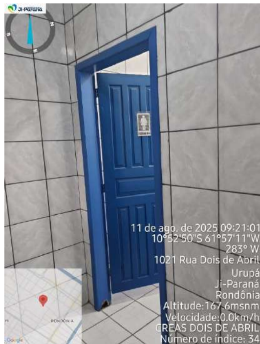
Figura 6: Banheiro de uso público com porta abrindo para dentro, sem barra e chapa de aço inox
