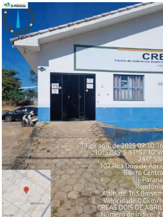
Figura 1: Entrada principal: rampa de acesso com inclinação errada.
