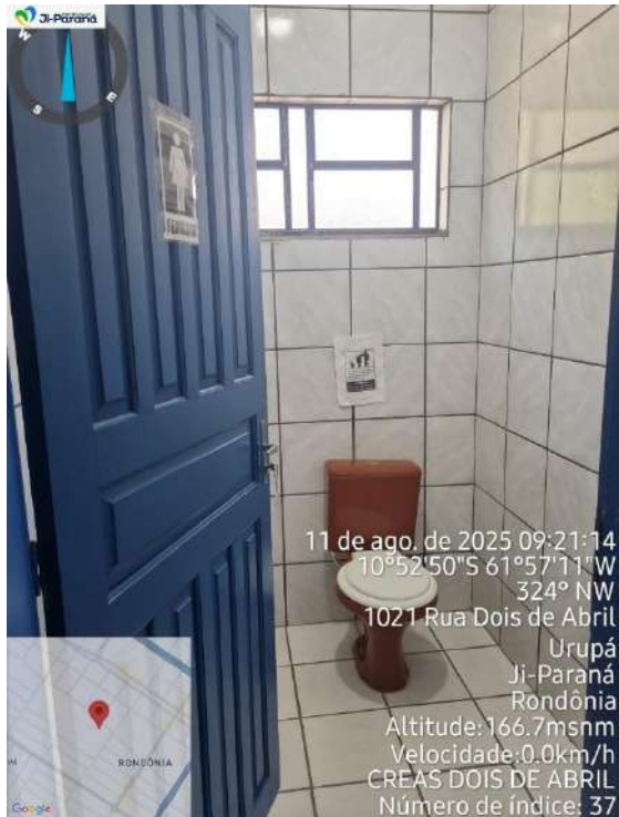
Figura 7: Banheiro de uso público com porta abrindo para dentro, sem barras de apoio no sanitário.
