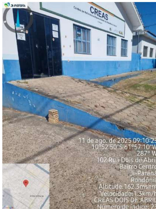
Figura 2: Entrada principal: rampa de acesso com inclinação errada.
